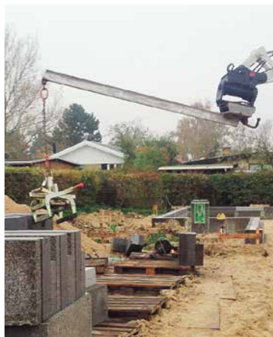
"Med kranarmen når vi rigtigt langt, og de store Skawblokke kan kun monteres med kran, så de tunge løft fra "gamle dage", hvor vi brugte almindelige Lecatermblokke, er helt væk," fortæller Anders Viekær.
