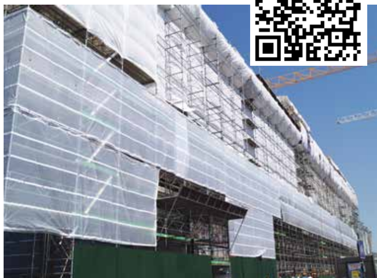
Frederiksberg Centret under ombygning.
