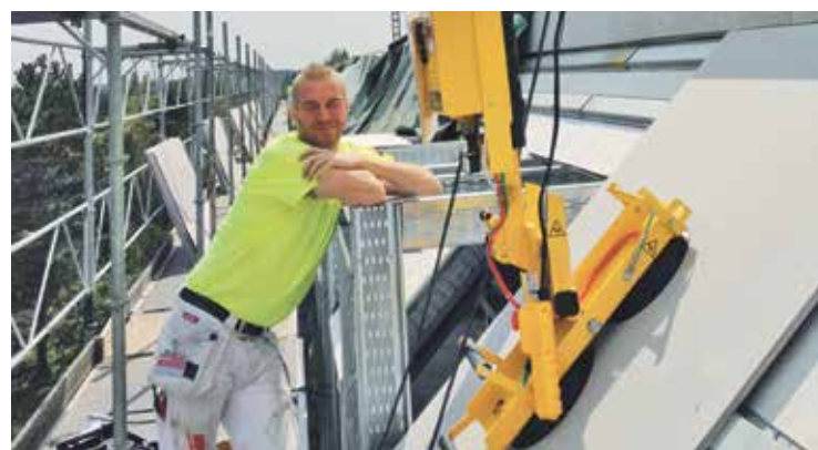
Et stativ, en lille kran og et sug var den simple, men meget funktionelle løsning.
